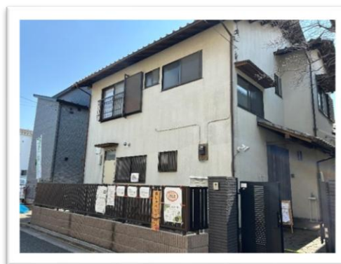
新事務所(2 階建て)の外観です
